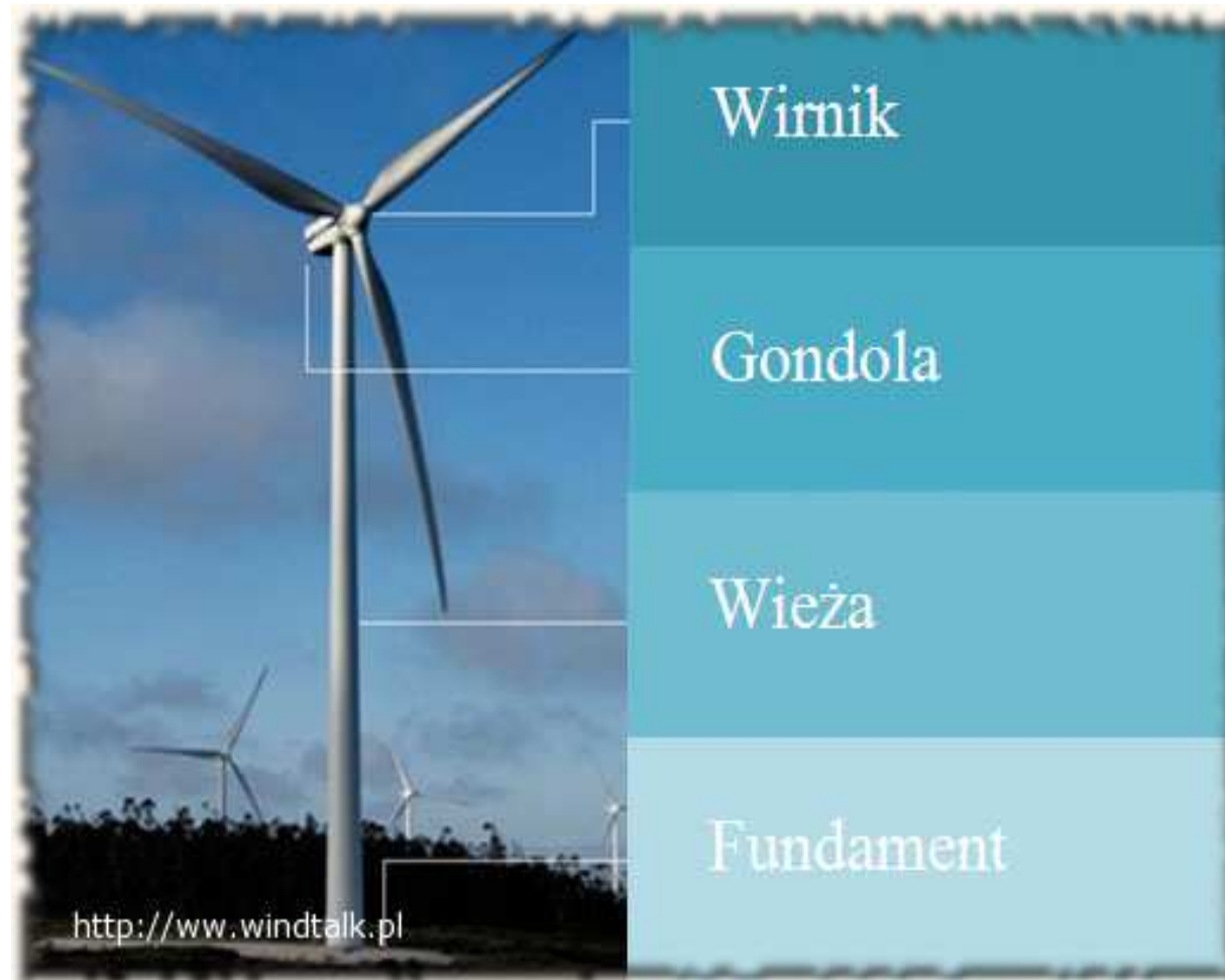
Rys. Elementy Turbiny wiatrowej. Źródło: www.windtalk.pl
